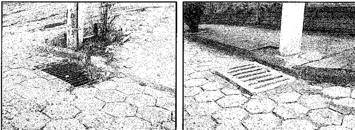
**Figura 7.166 – Causas de assoreamento**
