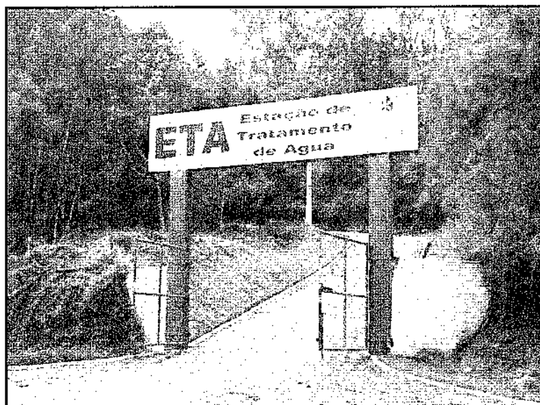
Figura 7.25 – Portal de entrada da ETA Sede de Urussanga
