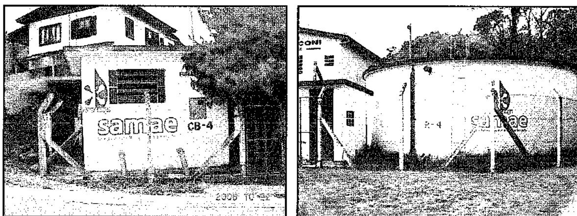
Figura 7.42 – Casa de bomba CB-04 e reservatório R-4, localizados na zona alta IV.
