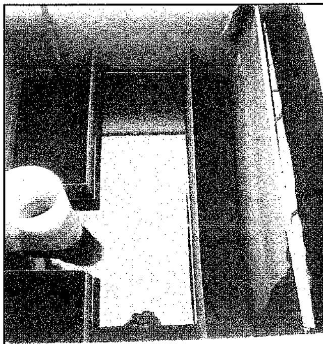
Figura 7.72 – Filtro rápido de fluxo descendente da ETA Rio Maior
