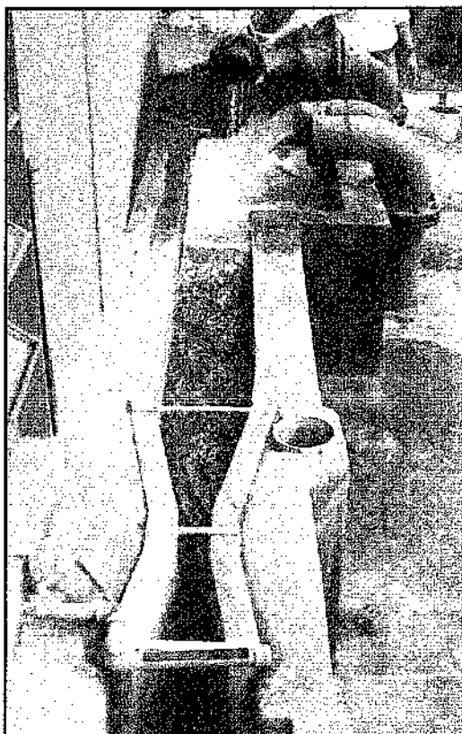
Figura 7.32 – Chegada das adutoras na ETA e a calha Parshall
